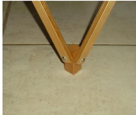
Das Gelenk besteht aus einem Klotz mit Schraube.
